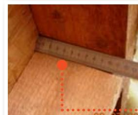
Эта стена способна вместить слой утеплителя толщиной всего 100 мм, тогда как требуется в два раза больше (в климатической зоне средней полосы глубина каркаса должна составлять 180–200 мм). Причём строители, похоже, решили затолкать в стену двойную порцию теплоизоляции. Увы, запоздалая «щедрость» не спасёт положения. Уплотнённая минеральная вата частично утрачивает свою теплоизоляционную способность
