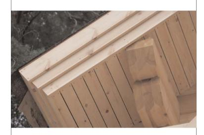
Вход в вентилируемый зазор тянется ввдоль всего свеса кровли его прикрывают прибитые в разбежку доски подшивки
