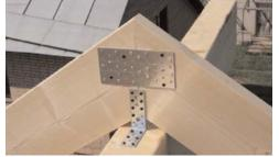
К коньковому брусу стропила закрепили уголком из оцинкованной стали
