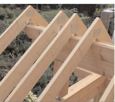
Сначала поднятые с двух сторон дома стропилины над коньковой балкой скрепили металлическими пластинами, используя 4 самореза (а). Затем соединение усилили ершеными гвоздями (б,в) - на каждое соединение их ушло ровно 30 шт. Таким образом в единый пакет собрали весь комплект стропил
