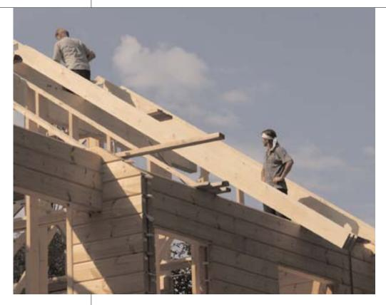
Как только сборка была закончена, стропильные НОГИ раздвинули вдоль конька (шаг стропил 600 MM) и закрепили к коньку металлическим и уголками, используя те же ершеные ГВОЗДИ
