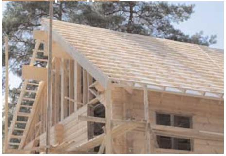
Стропильная система, подкровельный пирог и создающая вентилируемый зазор «наборная» обрешётка готовы - можно приступать к монтажу кровельного покрытия
