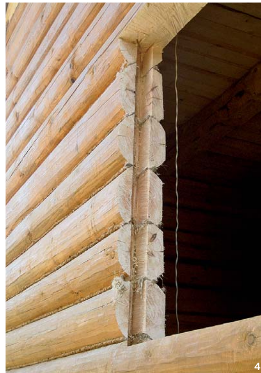
Последовательность установки окосочки с забивкой:
